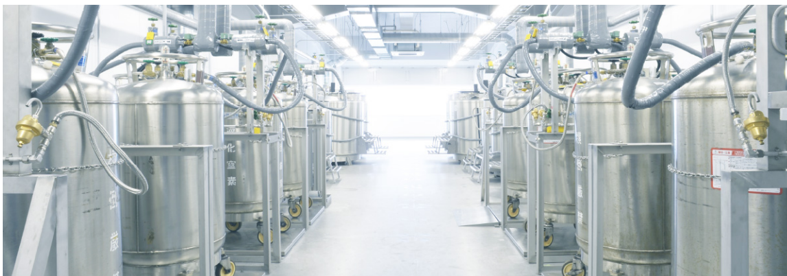
写真：Grace Bank が保管タンクを設置する、株式会社ステムセル研究所の細胞保管センター
